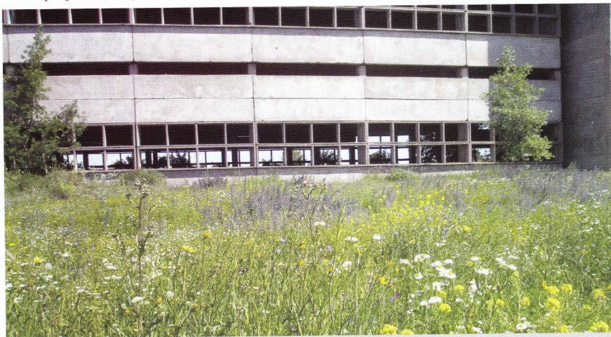
Рослини порушених територій (корпуси недобудованого заводу, м-н Підварки) (фото М. Шевери)
